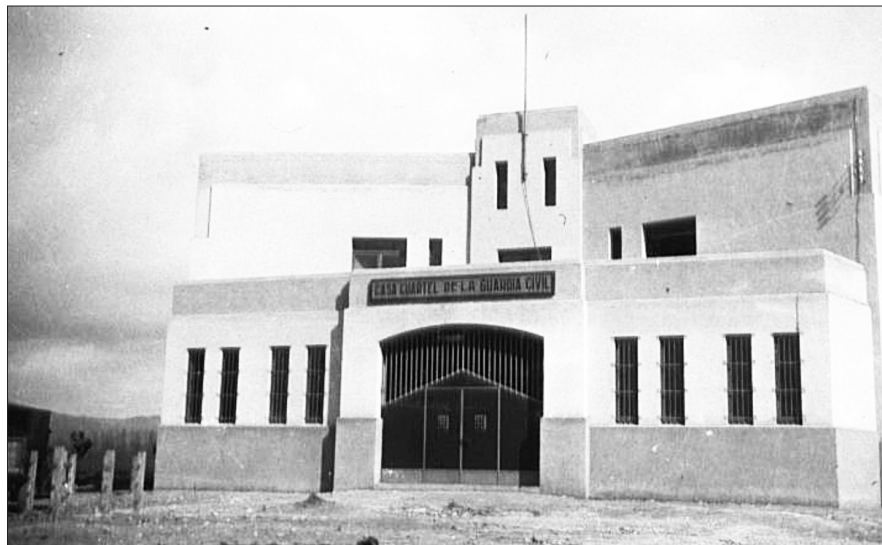
Façana de la caserna de la Guàrdia Civil del Prat, en finalitzar la seva construcció. Arxiu: Gerard Giménez.
