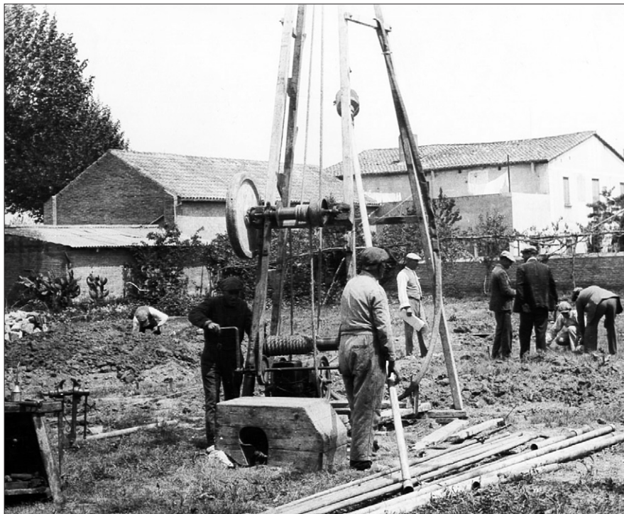
Construcció del pou artesià de la Caserna de la Guàrdia Civil i primers treballs de la delimitació dels espais de la futura caserna. Arxiu: Gerard Giménez .
