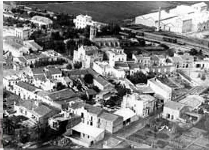
El Prat cap al 1928. Del conjunt d'edificis, en destaquen el temple parroquial, l'Ajuntament, el mercat i, al fons, La Seda.
