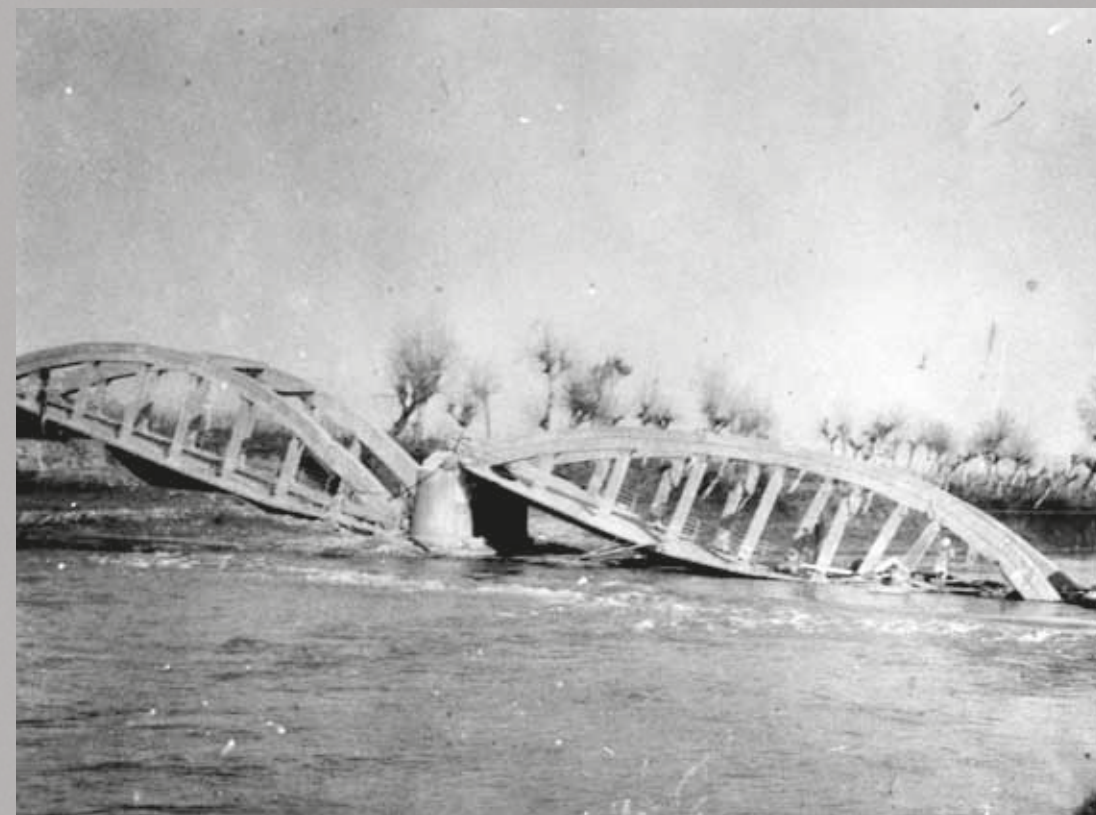
Totí els ponts van ser volats per retardar l'entrada de les tropes franquistes a Barcelona. El de Ferran Puig, que estava en mal estat i abandonat, es va haver d'habilitar per a poder travessar el riu.
