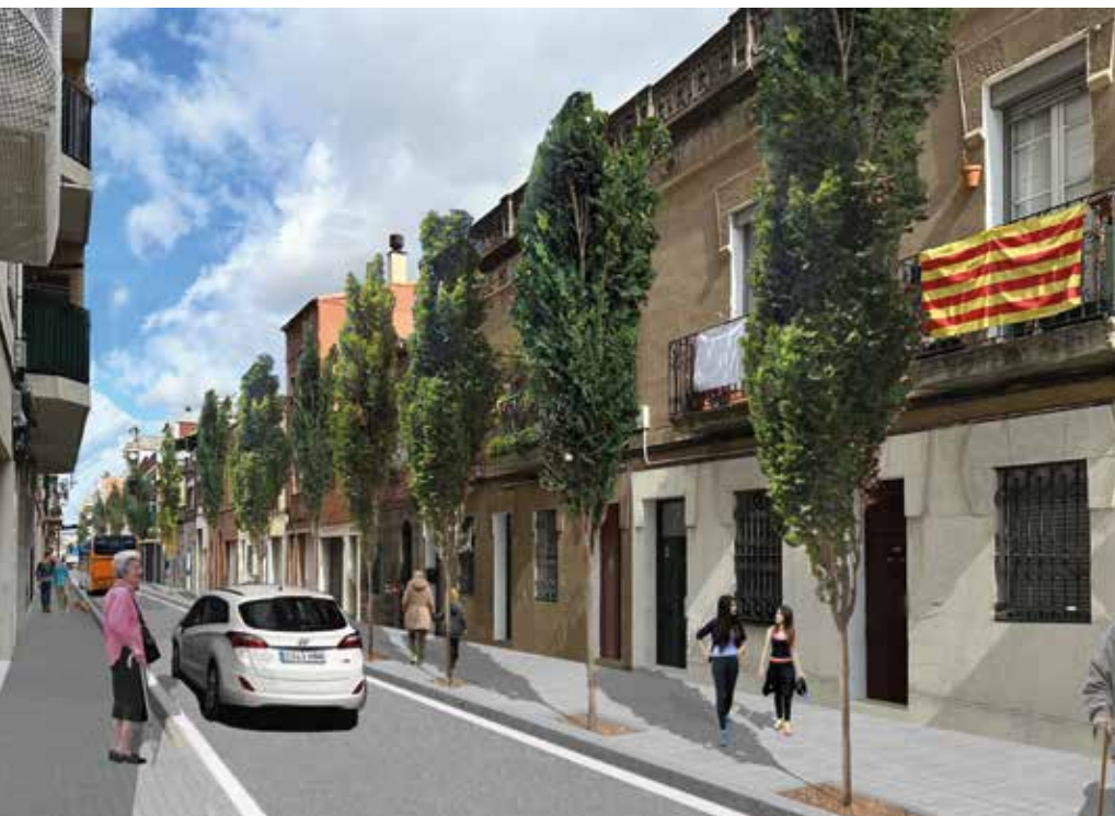
Imatge d'ordinador de l'aspecte que tindrà el carrer quan acabin les obres.
