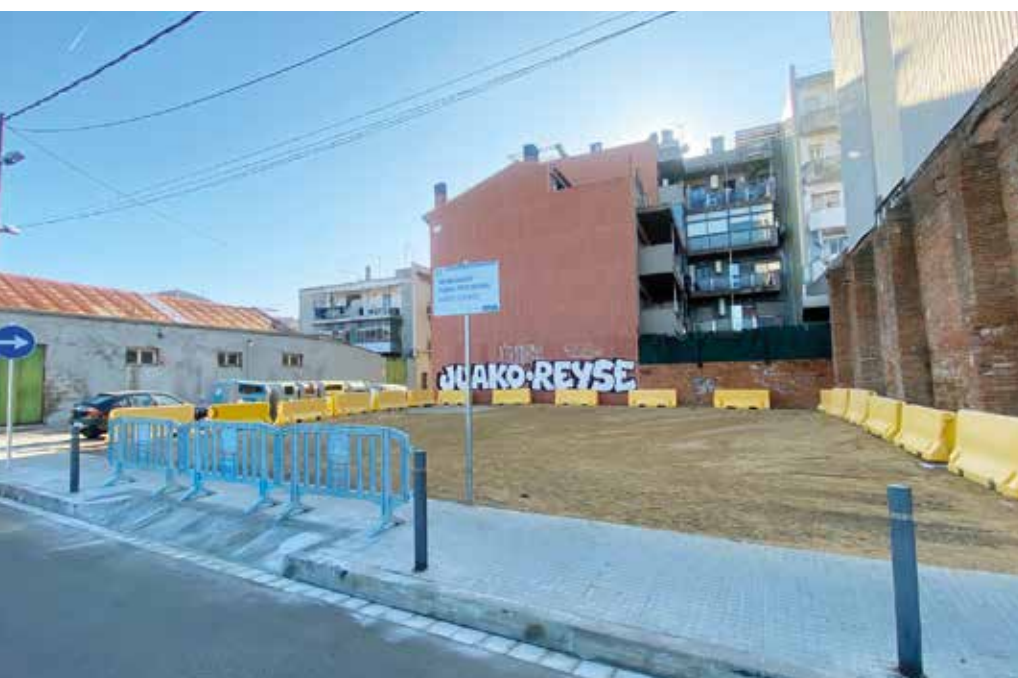
Espai que es destinarà a aparcament provisional mentre durin les obres.
