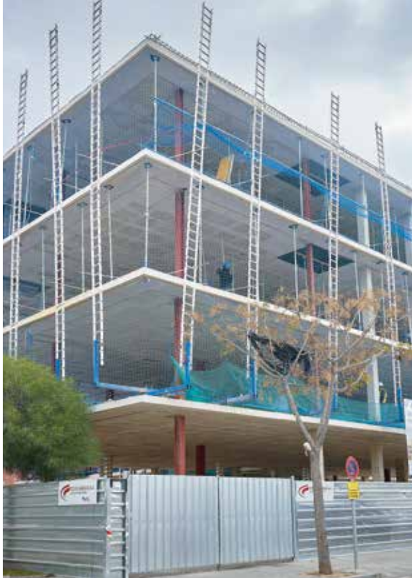
Residència municipal de gent gran i centre de dia, en construcció a l'Eixample Sud.
